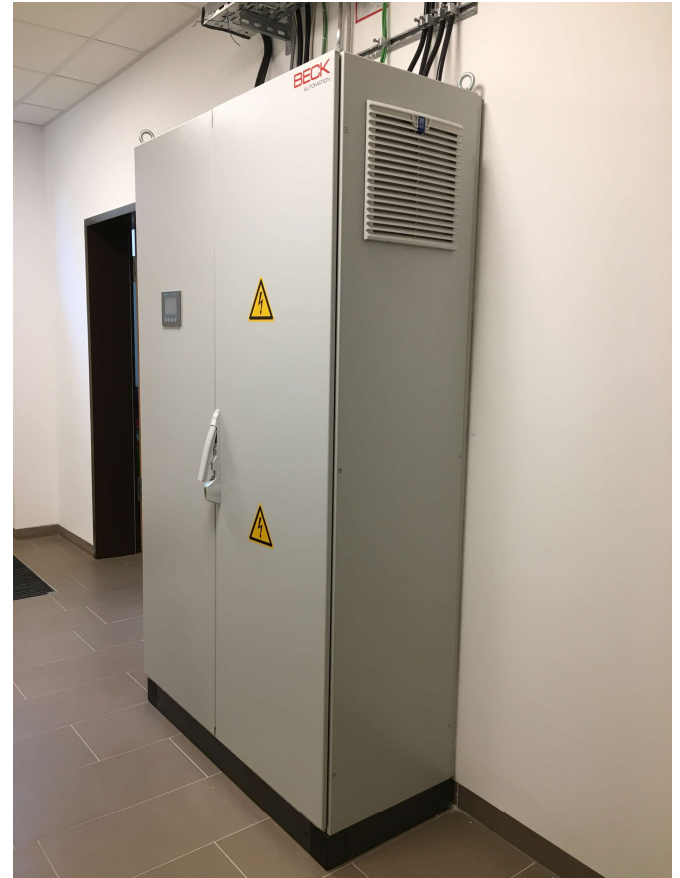
BECK BESS Leistungs- und Steuereinheit 60kW
