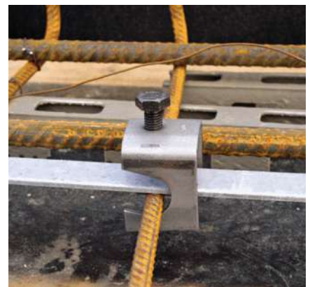
Bild 1: Elektrisch sichere Verbindung mit Armierungsanschlussklemme
