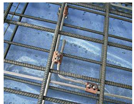
Bild 3: Schutz-, Blitzschutz- und Betriebs-erdung
