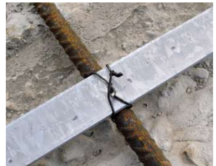
Bild 2: Verrödeln nur zur Lagefixierung – keine sichere elektrische Verbindung
